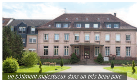
Un bâtiment majestueux dans un très beau parc
